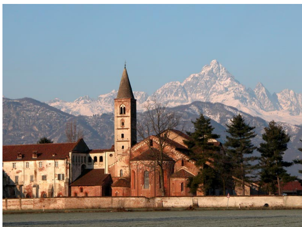
L'abbazia di Staffarda. Alle spalle il Mombracco e più dietro il Monviso
